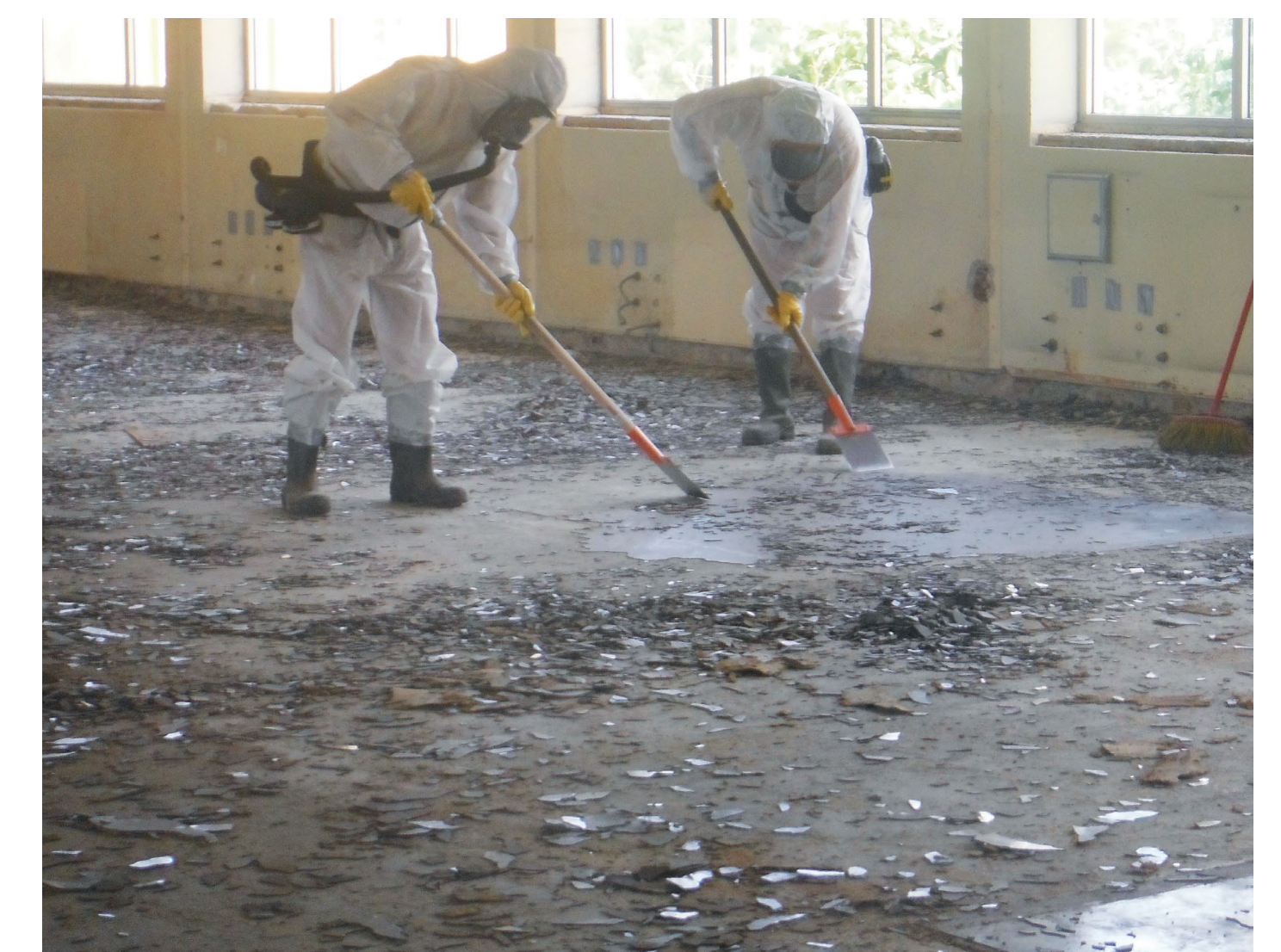
Trabajos de descontaminación de una planta industrial - retirada de materiales con amianto (pavimentos de vinilo).
